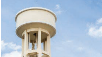
خزانات المياه water tanks
